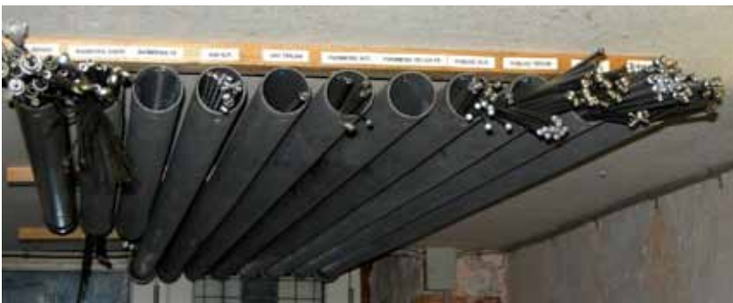
Kabler i lange baner på lageret.
