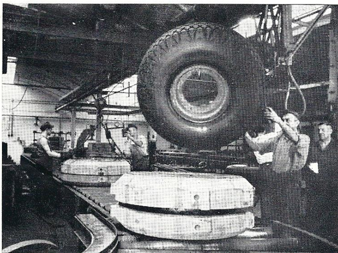
Paa Fulda fremstilles dæk i alle størrelser til traktorer, lastvogne, personbiler og Vespaer. I lange rækker staa de store autoklavepresser, der kan tage op til 12 ringe paa een gang.
