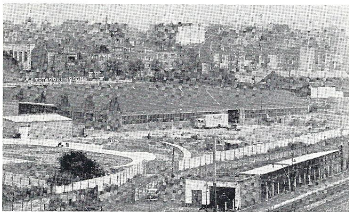
Samlehallerne hos M.I.S.A. Foran til venstre ses prøvebanen af cement ved siden af jernbanesporet ind til fabrikkens, saa alle reservedele kan aflæsses direkte fra banevognene og ind paa lageret.
