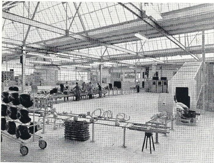
Her er sprøjtekabiner og tørre-kanal paa M.I.S.A. Til venstre afpudses chassiserne, inden de bliver grundet og sprøjtelakeret. Derpaa kører de langsomt gennem tørrekanalen til højre i billedet, hvorefter de underkastes en minutios kontrol, inden de gaar videre til samlebaandet.
